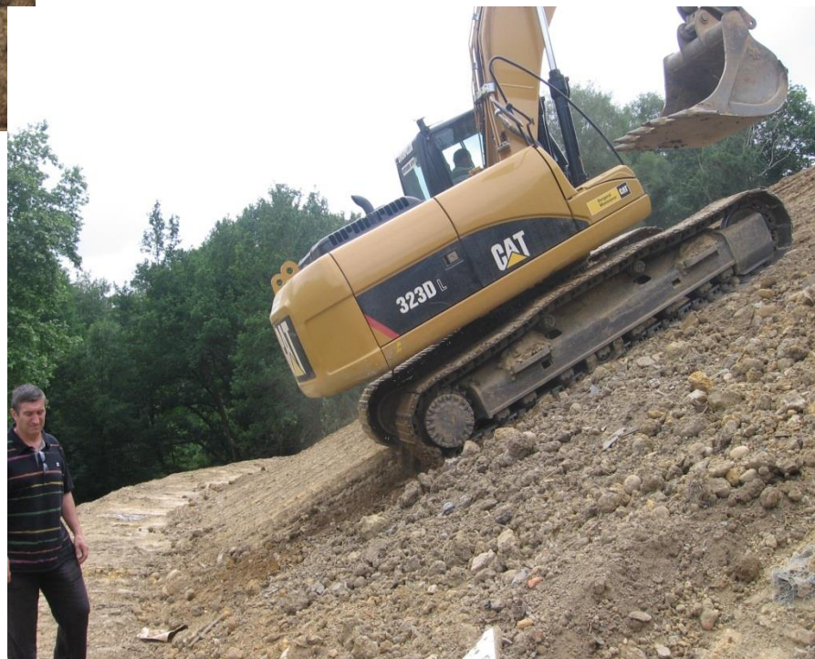
ANOS : création d'un chemin à mi-hauteur pour casser la pente et confortement de la route avec des enrochements
