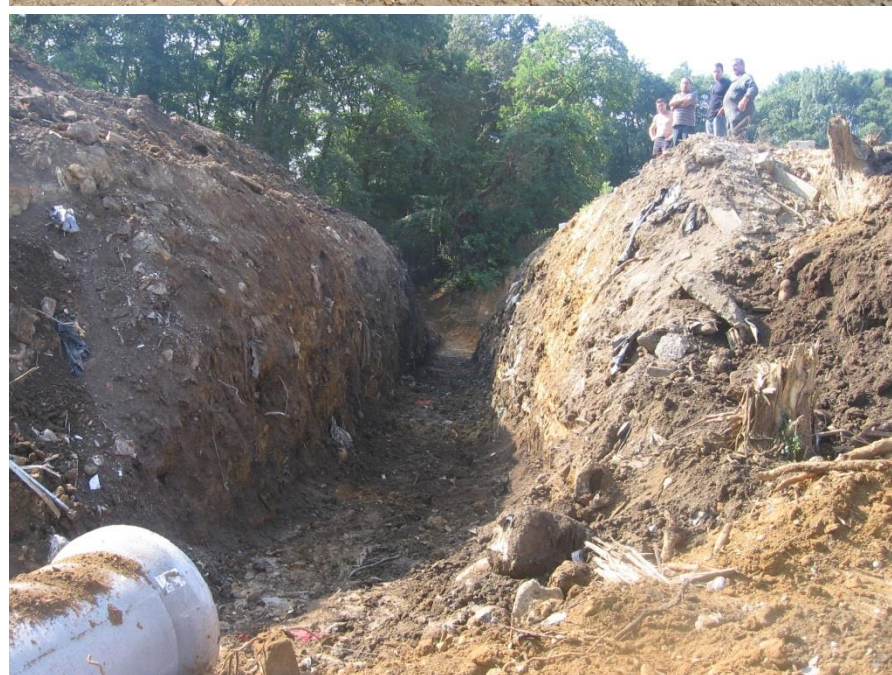
BUROS Bourlat : canalisation du ruisseau à travers le massif de déchets après autorisation Police de l'Eau
