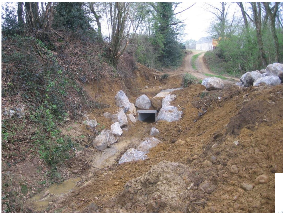
ABERE : création de dalot pour le passage du ruisseau
