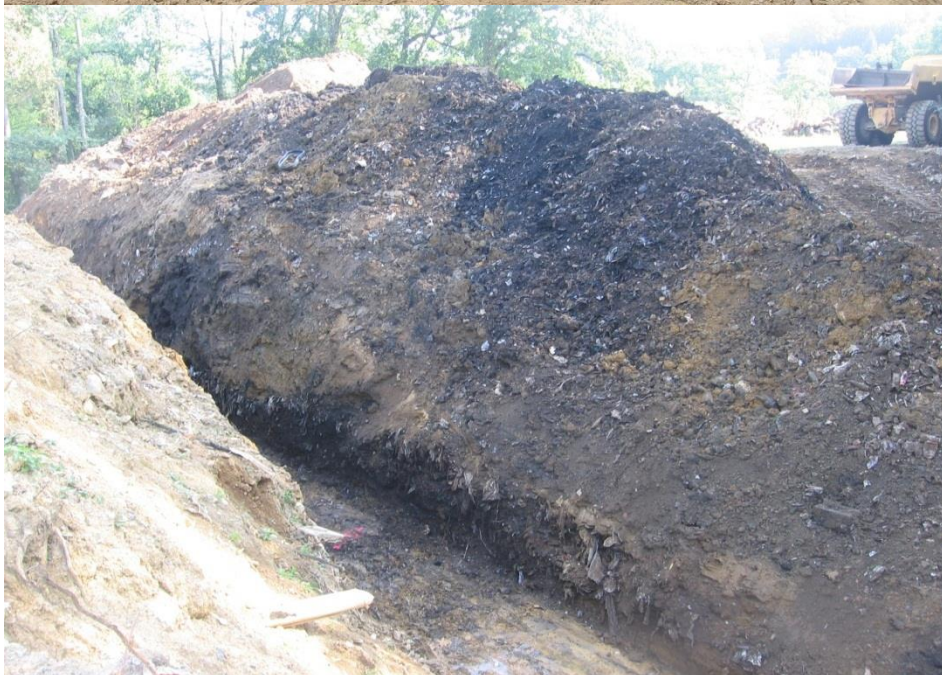
BUROS Bourlat : canalisation du ruisseau à travers le massif de déchets après autorisation Police de l'Eau
